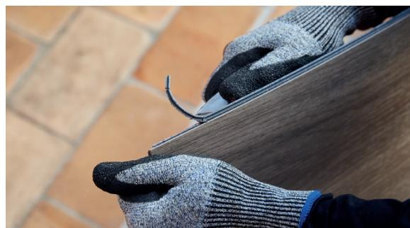
Установите панели с обрезанными краями около стен. Установите около стены распорные клинья, чтобы обеспечить необходимый температурный зазор и неподвижность панелей, а также их абсолютно ровную и 100% правильную укладку и защелкивание.
